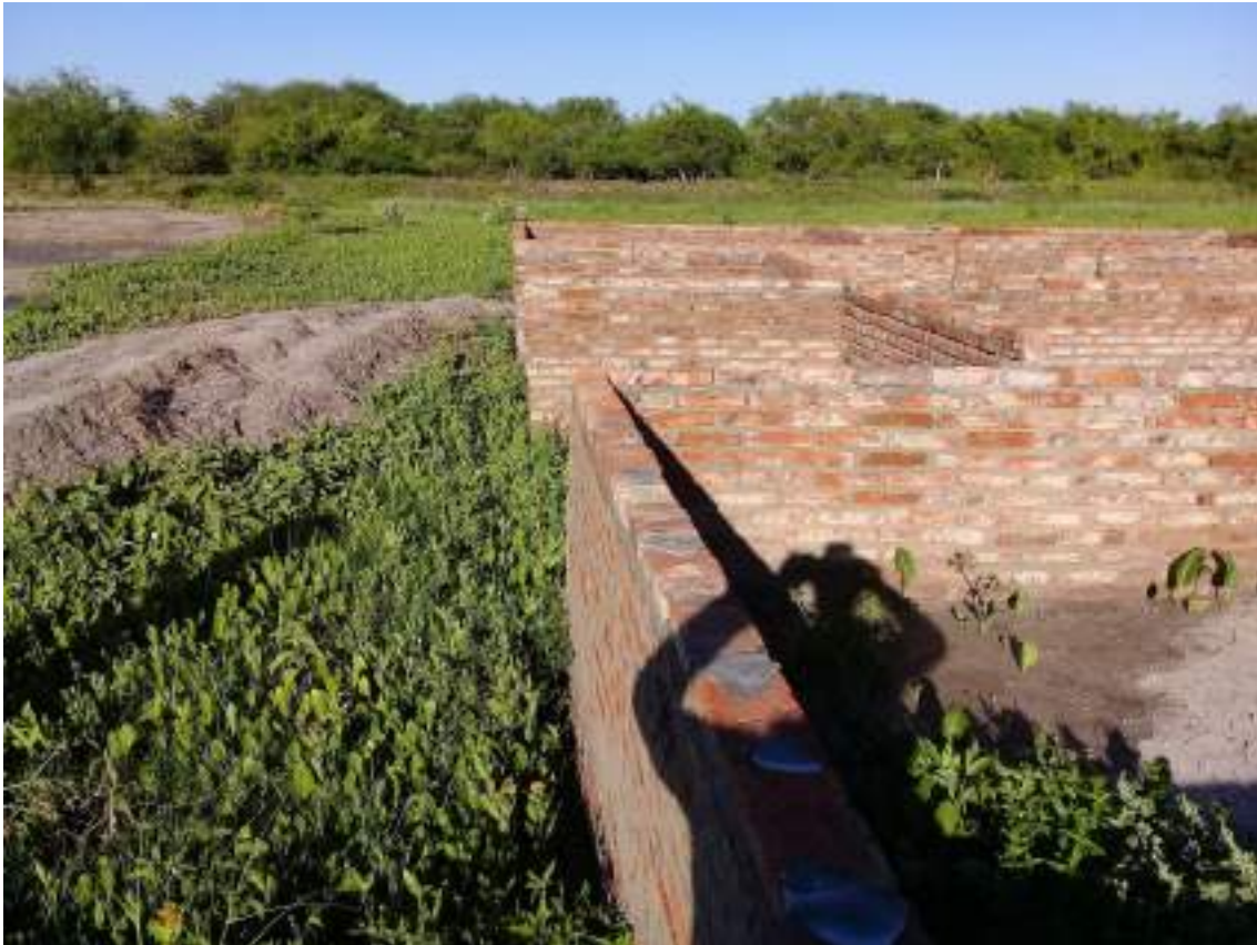
Ilustración 5 Alteo interior viviendas
