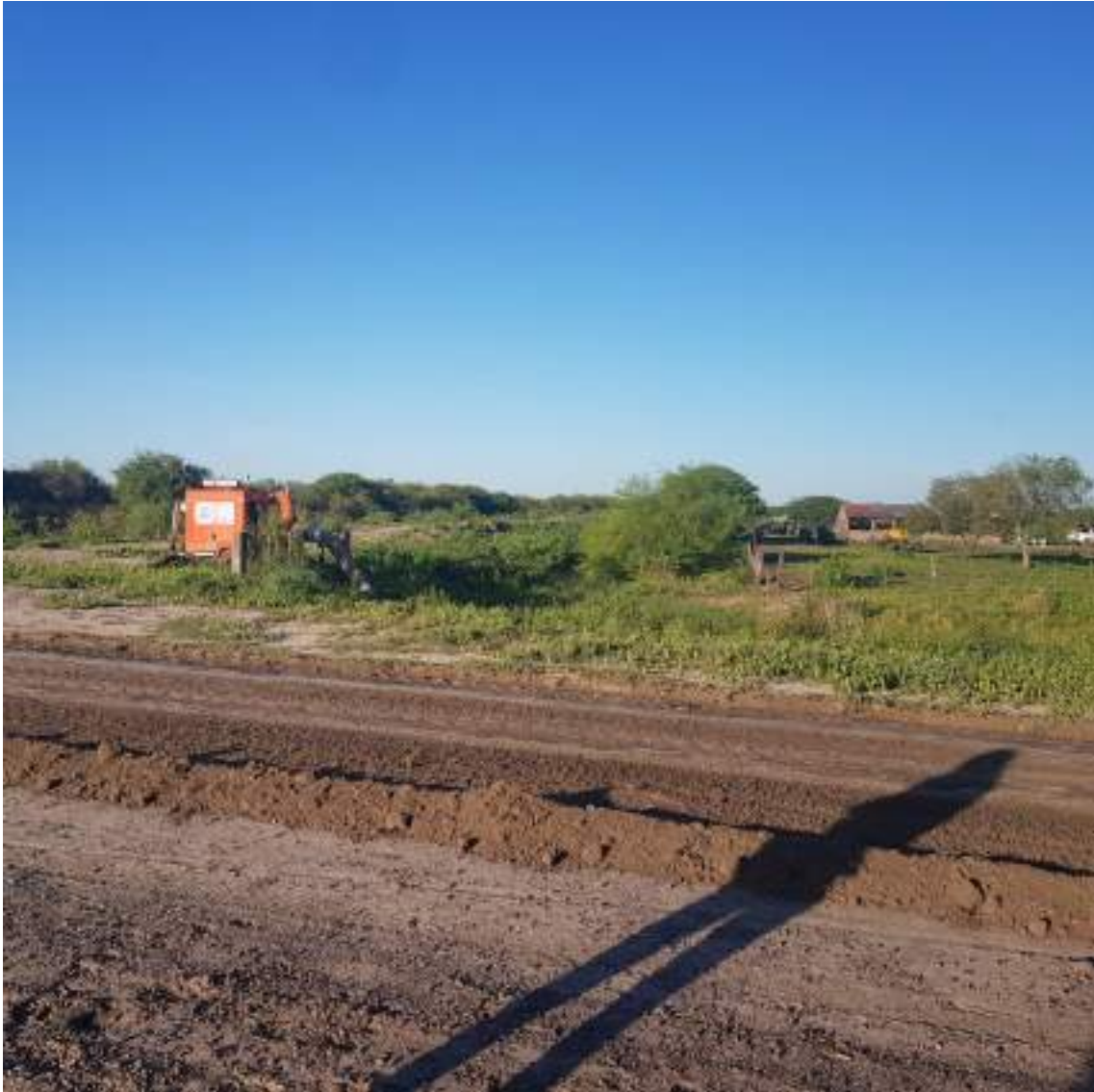
Ilustración 1 visualización de la estación de bombeo desde RP3
