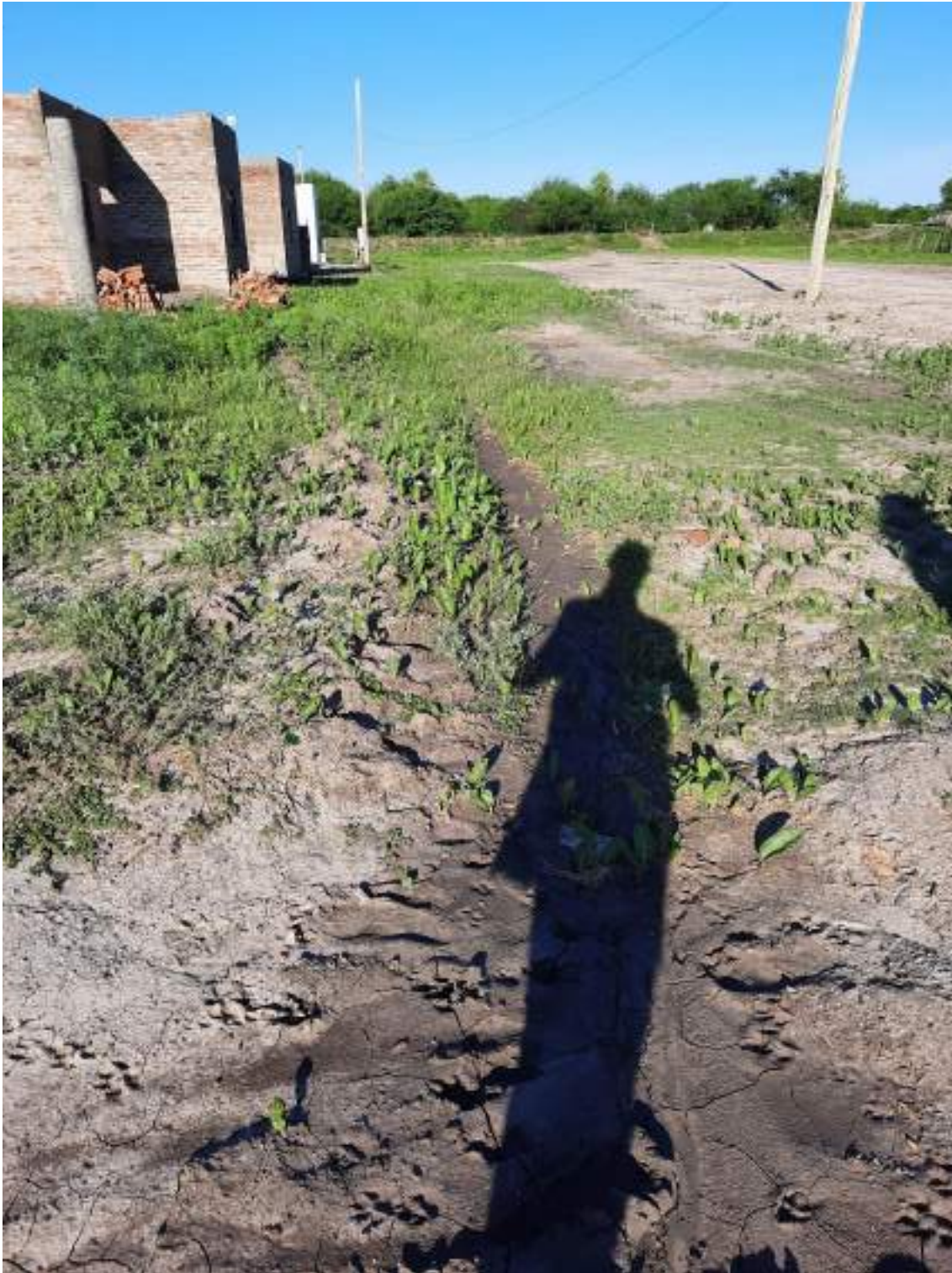
Ilustración 12 Drenaje interno Los Amores
