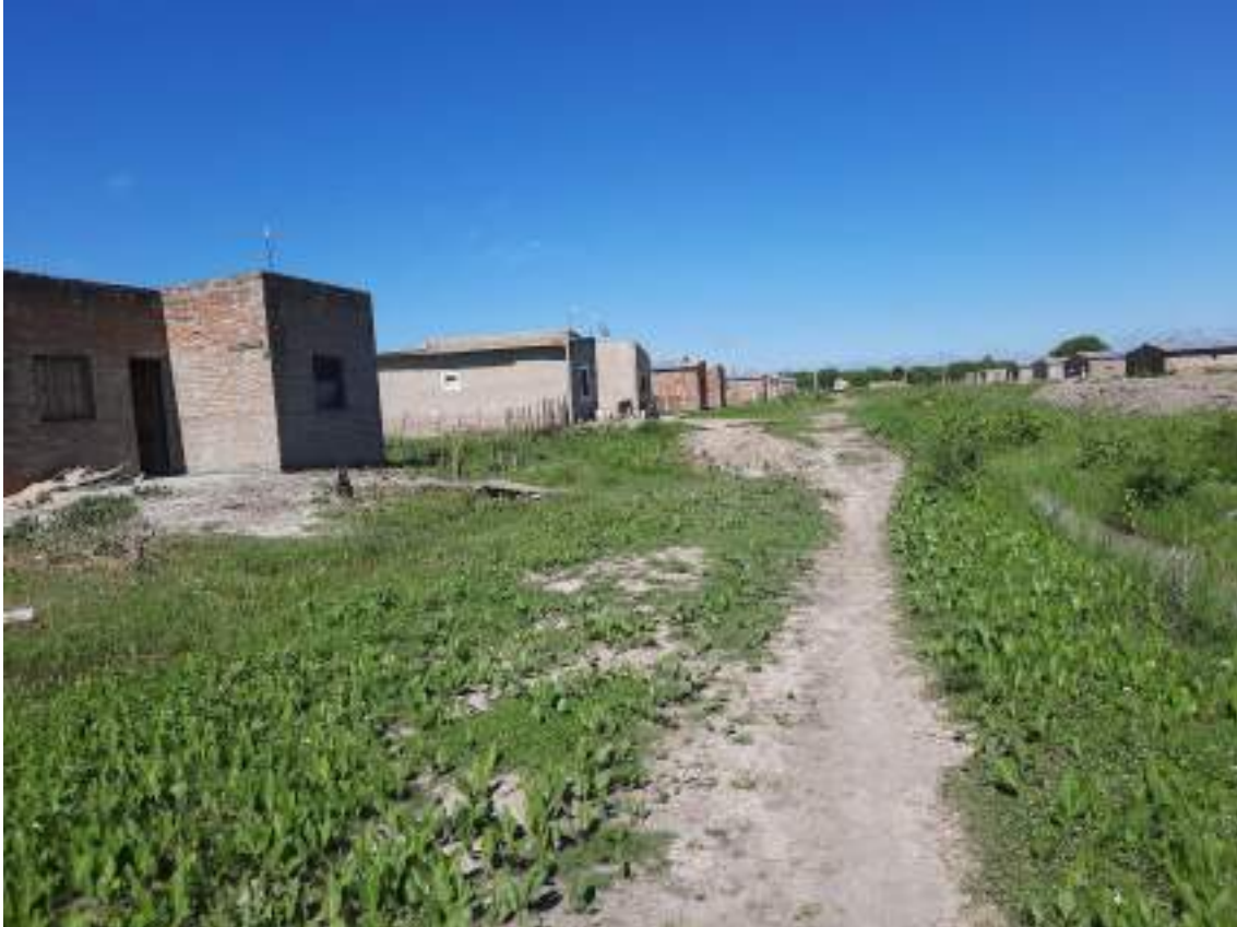
Ilustración 15 Alteo de viviendas
