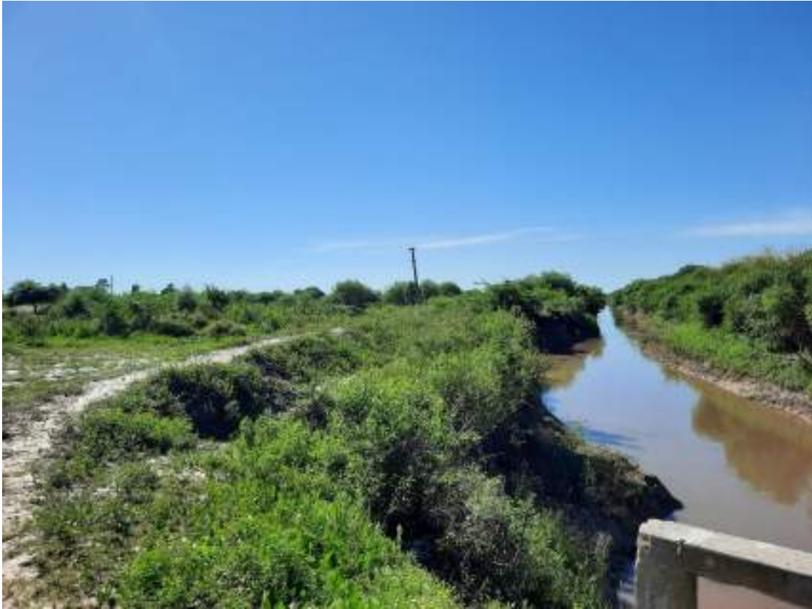
Ilustración 19 Defensa suroeste a reacondicionar
