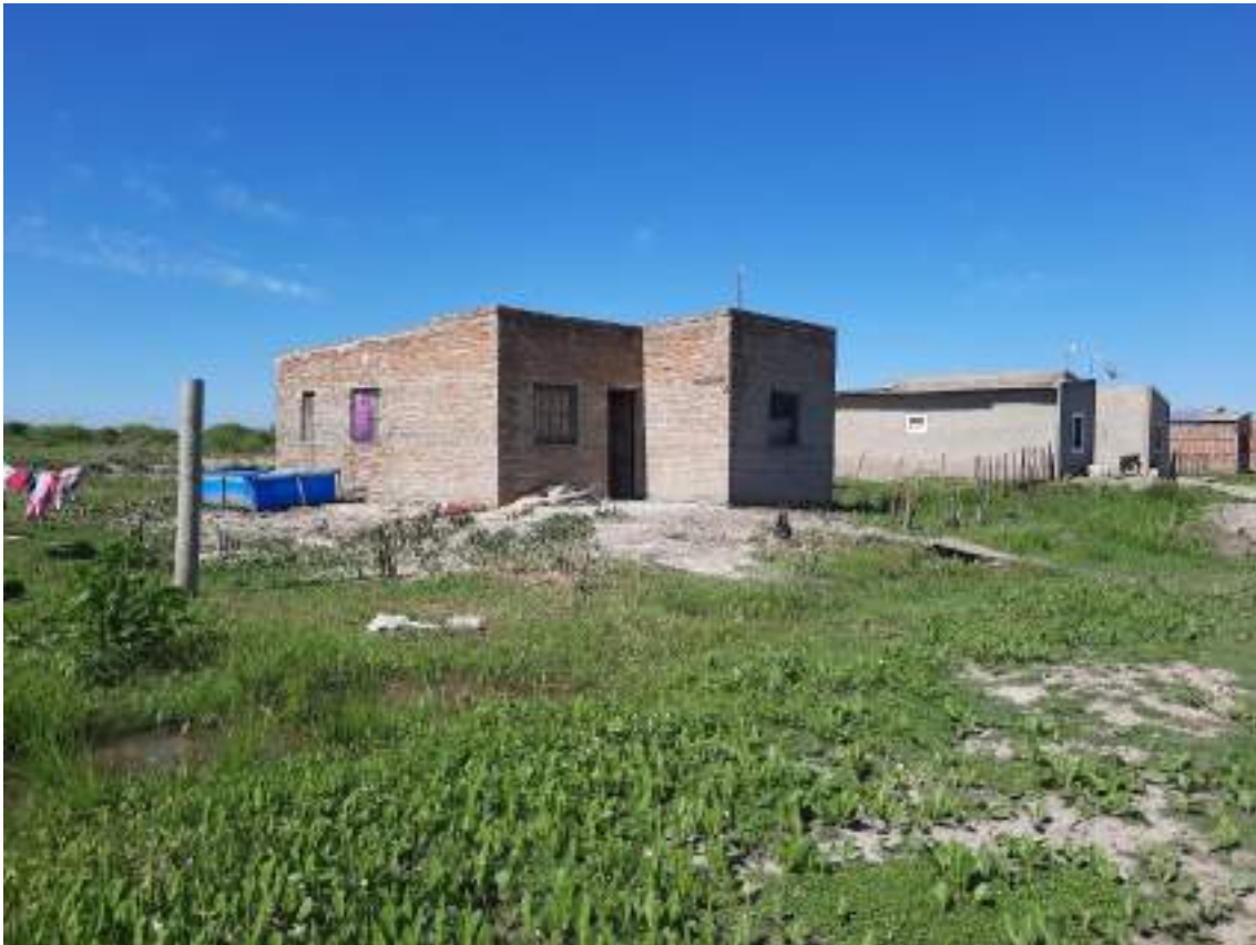
Ilustración 14 Alteo de viviendas
