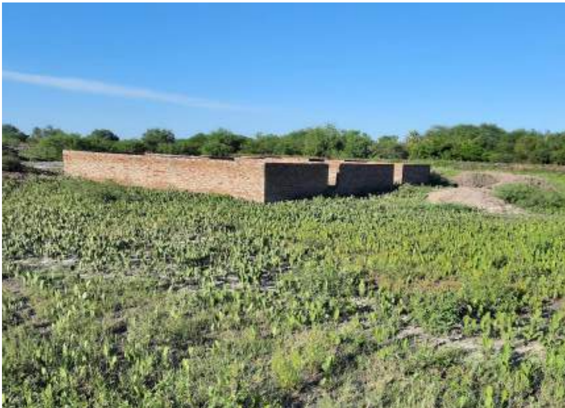
Ilustración 10 Alteo de viviendas
