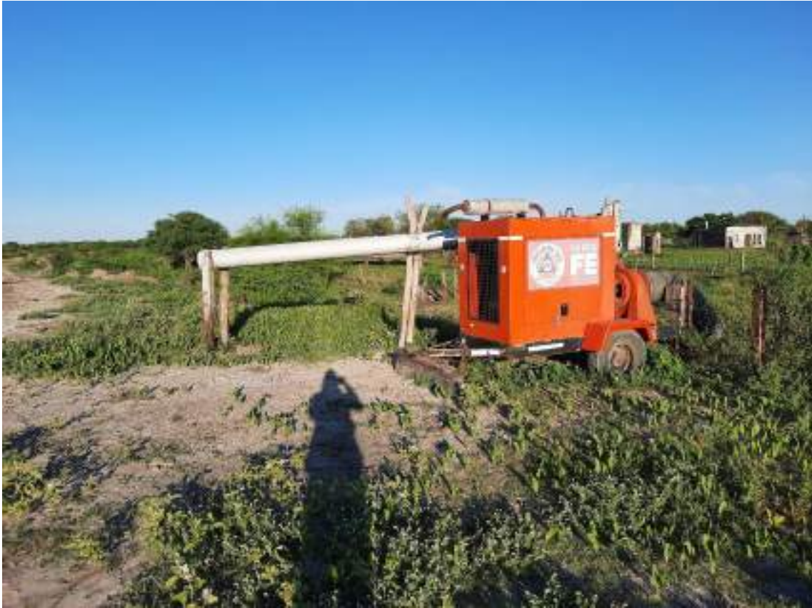
Ilustración 17 Motobomba actual vista desde RP3
